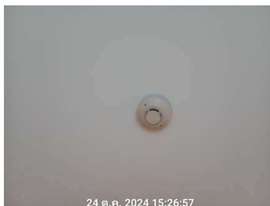
รูปที่ 2.46 อุปกรณ์ตรวจจับควัน
